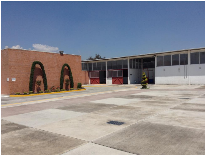
Instalaciones del hospital de equinos
